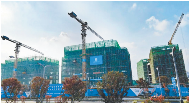
建设中的成都未来智创产业园C区。图据成都高新公众号
