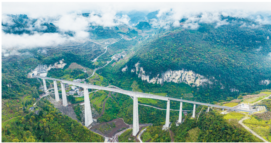
叙毕铁路冯家寨特大桥 蜀道集团供图
