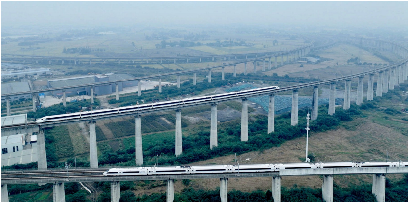
列车在川青铁路上试运行。
