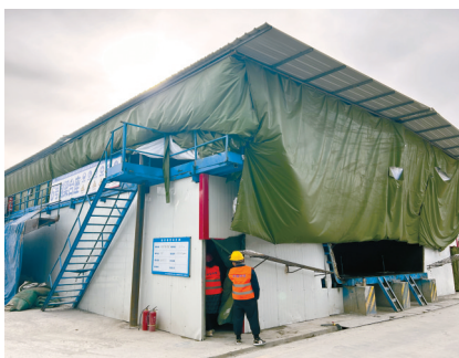
给梁片“穿衣盖被”保温。 曹菲摄
