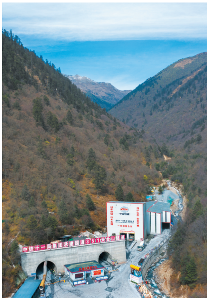
夹金山隧道波日沟工地外景。
