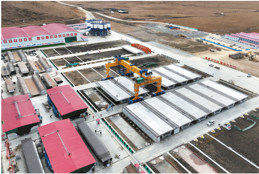
若尔盖梁场首批箱梁完成预制。 成兰铁路公司供图
