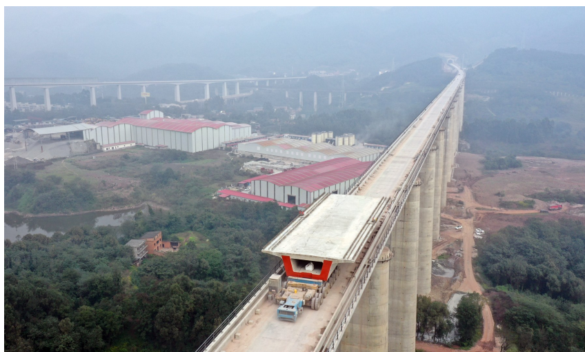
楼湾特大桥架梁现场。京昆高铁西昆公司供图
