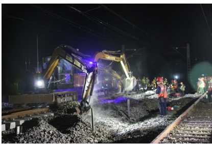
施工现场。成都工务大修段供图
