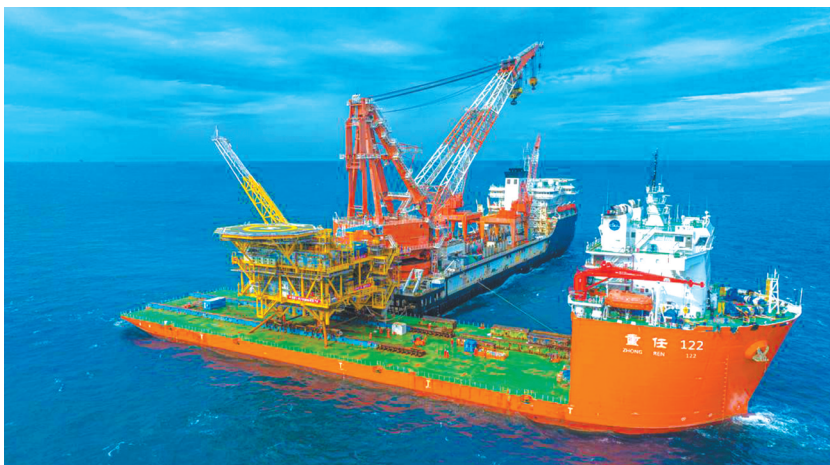
重122吨的乐东10-1气田上部组块靠近海洋石油201船。受访者供图
