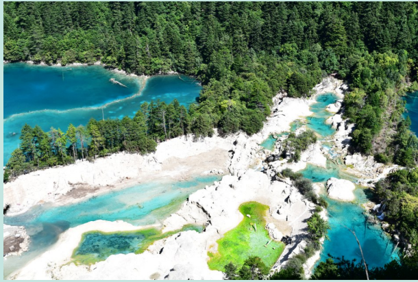
▲ 2017年“8·8”九寨沟7.0级地震导致火花海堤坝溃决,形成长40米、宽12米、深15米的决口,湖泊干涸。图据九寨沟管理局
