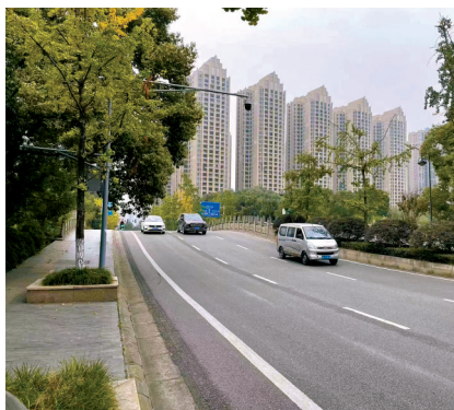
桥坡度大，在坡下看不见前方的道路情况。
