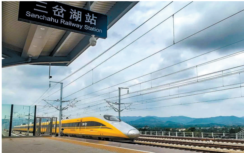
正在进行联调联试的成都至宜宾高速铁路。(图据西南铁路)
