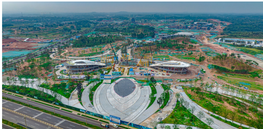
建设中的2024成都世园会主场馆。
