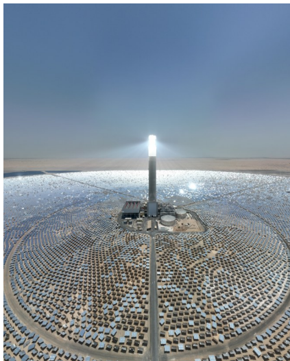
这是2022年8月15日在阿联酋迪拜拍摄的上海电气迪拜光热光伏复合项目(无人机照片)。位于阿联酋迪拜的700MW光热和250MW光伏复合项目由上海电气集团股份有限公司总包，装机规模大、技术标准高，助力阿联酋实现清洁能源目标。 新华社发
