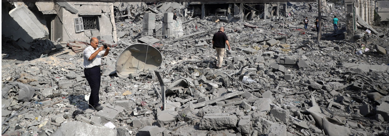
10月10日，在加沙城，人们查看被以色列空袭炸毁的建筑废墟。新华社发
