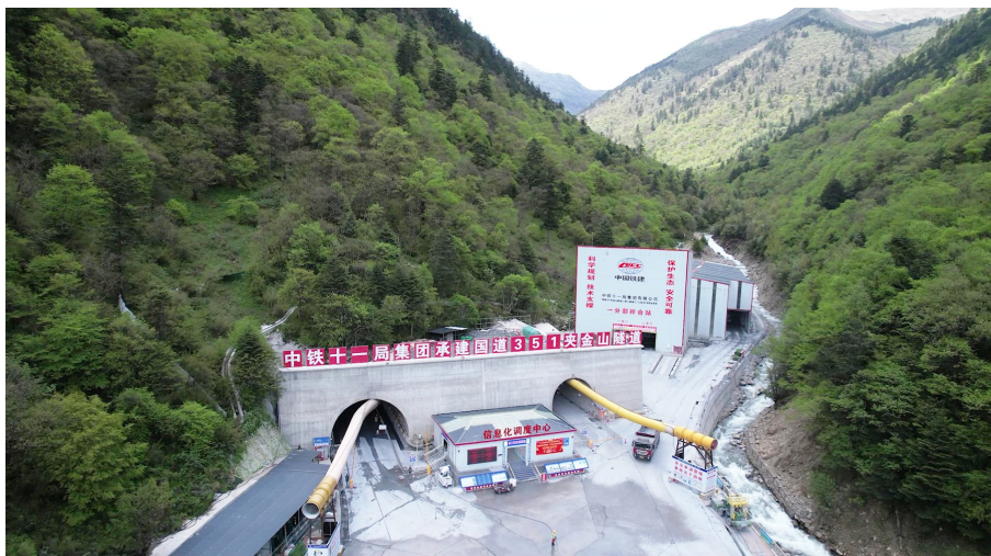
国道351线夹金山隧道洞口。交通运输部供图
