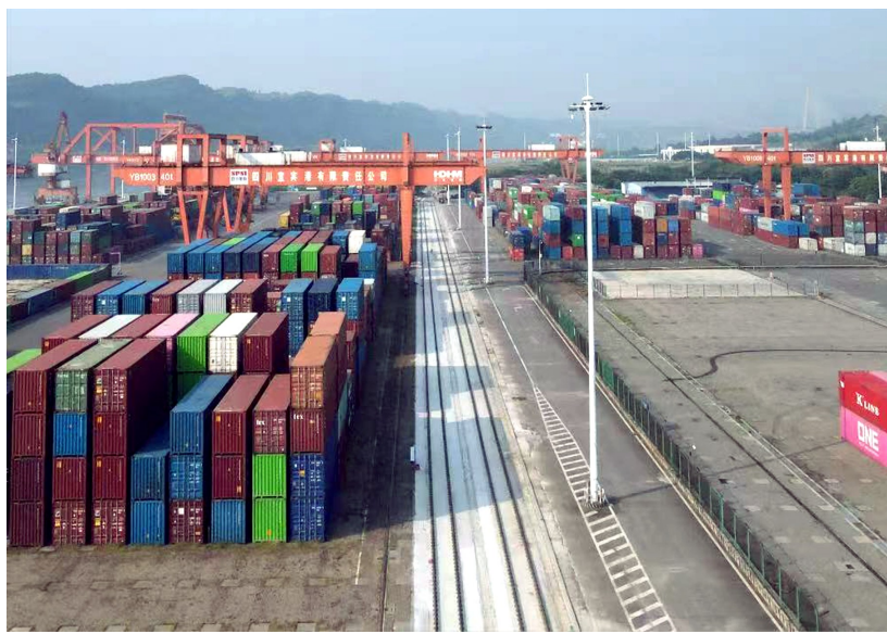
宜宾港铁路集疏运中心专用铁路港区段。(中铁八局供图)
