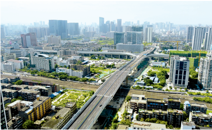
五块石高架桥跨越二环路及火车北站西侧铁路咽喉区。
