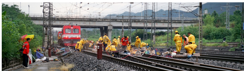
重庆工务段职工在兴珞线团结村站进行道岔钢件更换作业。张凯 摄
