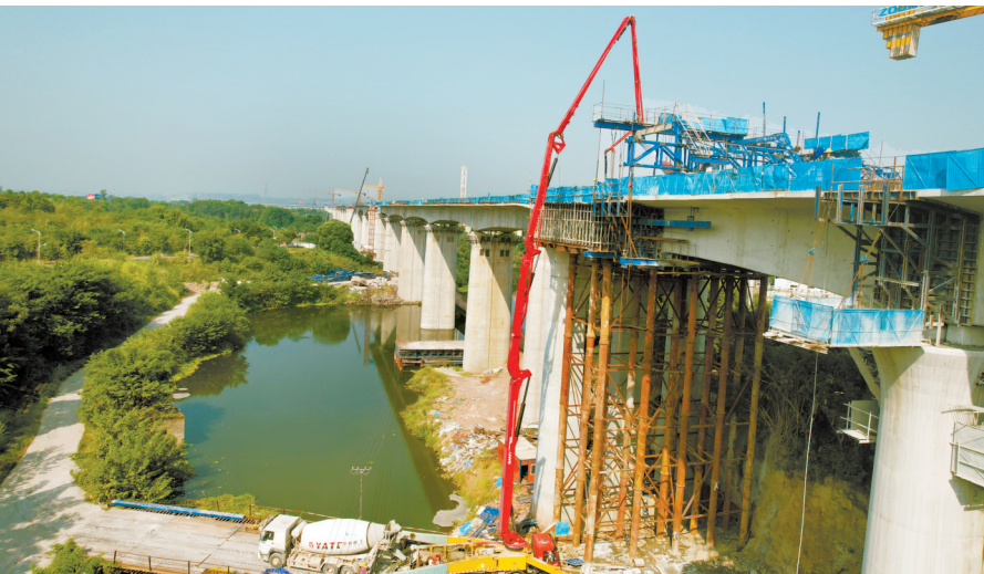
三百梯水库道岔特大桥连续梁合龙浇筑现场。京昆高铁西昆公司供图
