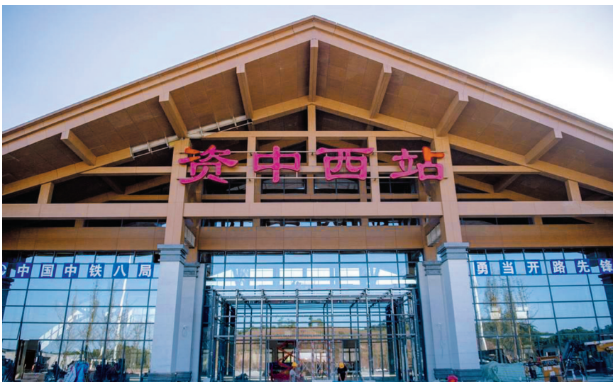
采用川式建筑风格的资中西站。成兰铁路公司供图
