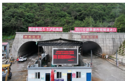
泸石高速杵坭隧道洞口。蜀道集团藏高公司供图
