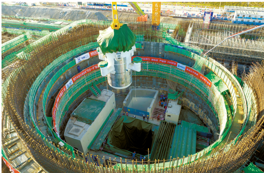
“玲龙一号”反应堆核心模块吊装现场。
