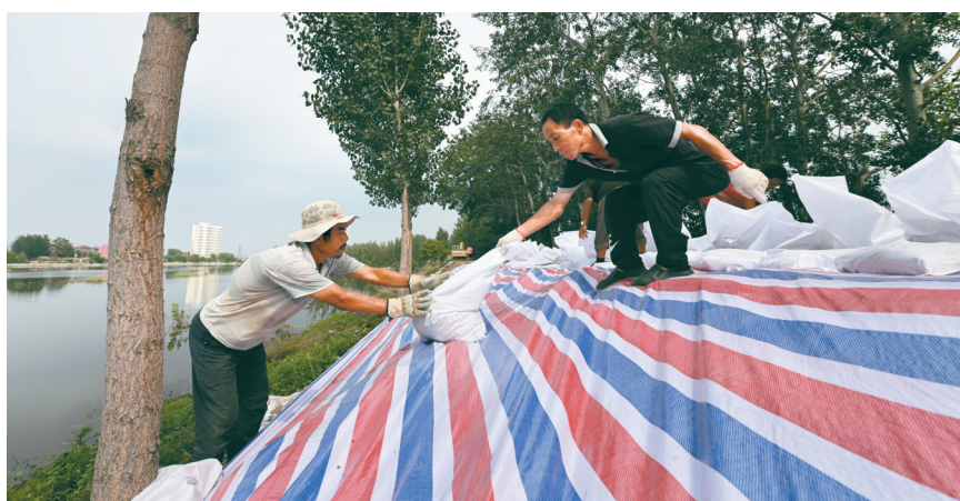
8月10日,在天津市静海区大清河台头段南堤,抗洪人员在加固堤坝。新华社发
