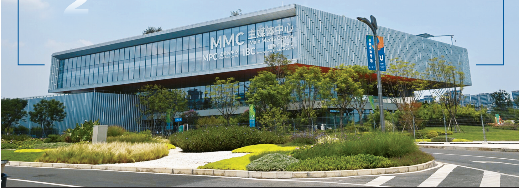
7月25日,成都大运会主媒体中心(MMC)正式启用,迎接来自世界各地的媒体记者。雷远东摄
