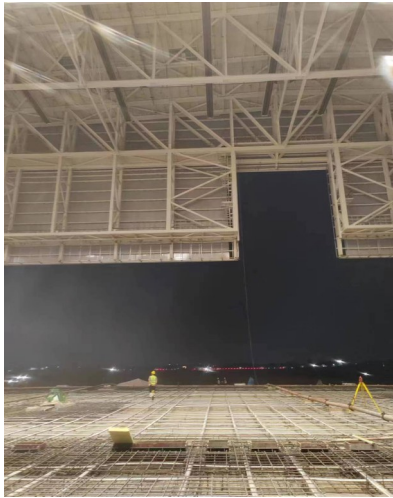
正在加快推进建设的空客成都项目。
