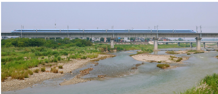
CR300AF复兴号试验动车组进行川青铁路联调联试。成兰铁路公司供图
