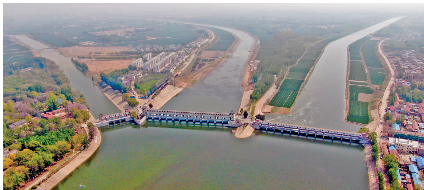
山东省德州市武城县四女寺枢纽航拍图。
