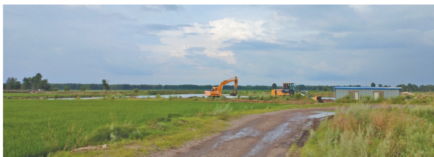
7月10日,洮儿河西岸边,挖掘机在平整场地,官方称是为后续修便民桥做准备。
