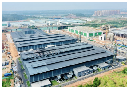
遂宁市蓬溪县“锂电之都拓展区”。
