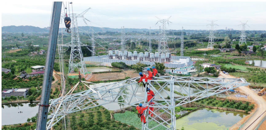
电力工人在开展组塔作业。
