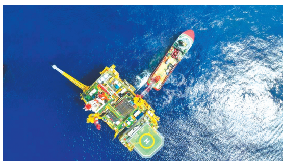
“海基一号”钻采平台正在进行物资吊装作业。
