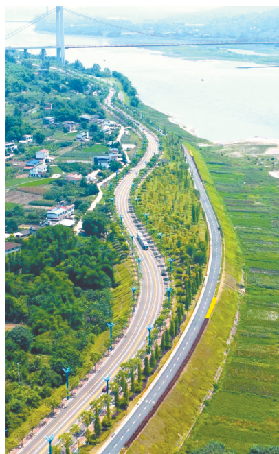
6月26日,宜宾智能轨道快运系统T4线正式启动试运行。
