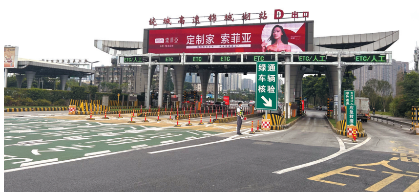
成都绕城高速锦城湖收费站D出口将中间三个收费岛收窄后，新增一条车道。
