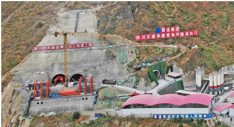
黄角坪隧道双幅贯通。蜀道集团供图
