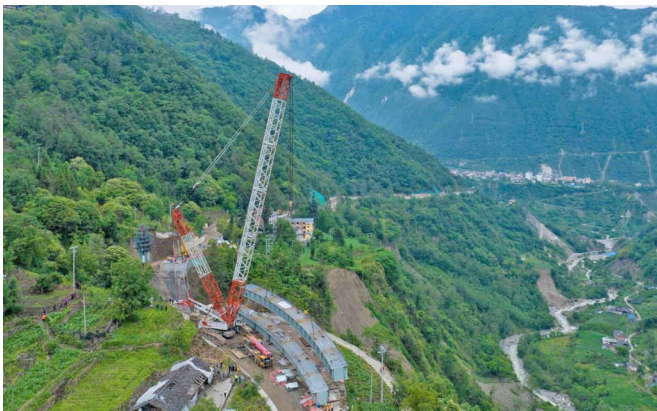
海螺沟景区道路灾后恢复重建项目迎来新进展:嘎木沟大桥钢箱梁顺利完成架设。
