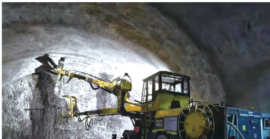
峨汉高速大峡谷隧道施工现场。四川公路院供图
