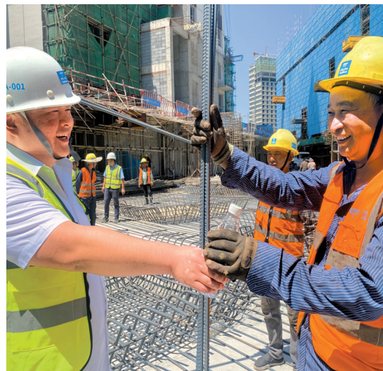
高温下的工地建设者。排名全国第三。
