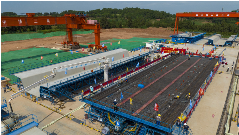
成达万高铁首孔40米预制箱梁浇筑现场。成达万高铁公司供图
