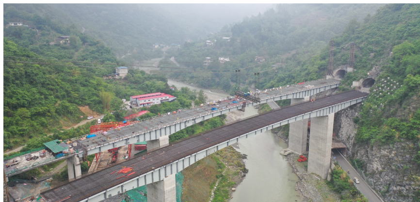
九绵高速控制性工程桑园子大桥合龙。
