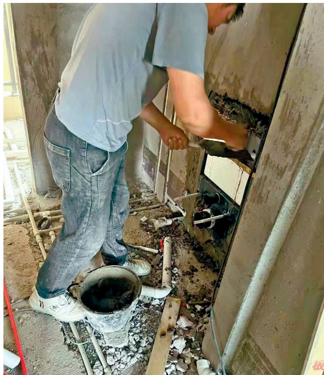
楼上邻居正将厨房改装成卫生间。受访者供图
