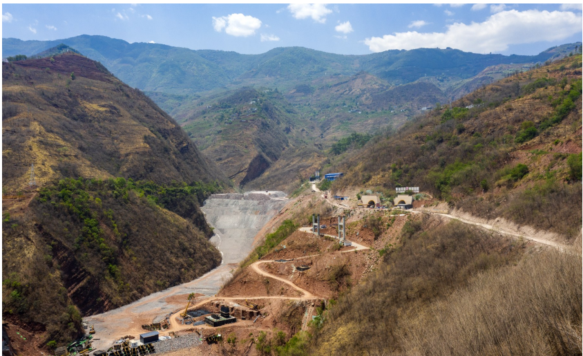
沿江高速金江隧道施工现场。蜀道集团供图
