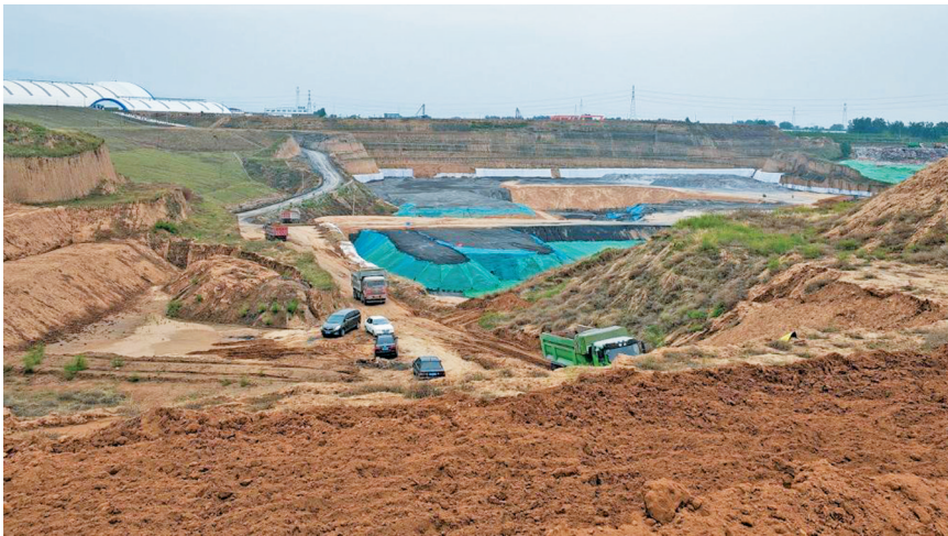
5月10日拍摄的平遥县晟顺绿化建设公司粉煤灰填埋场。图据新华社客户端
