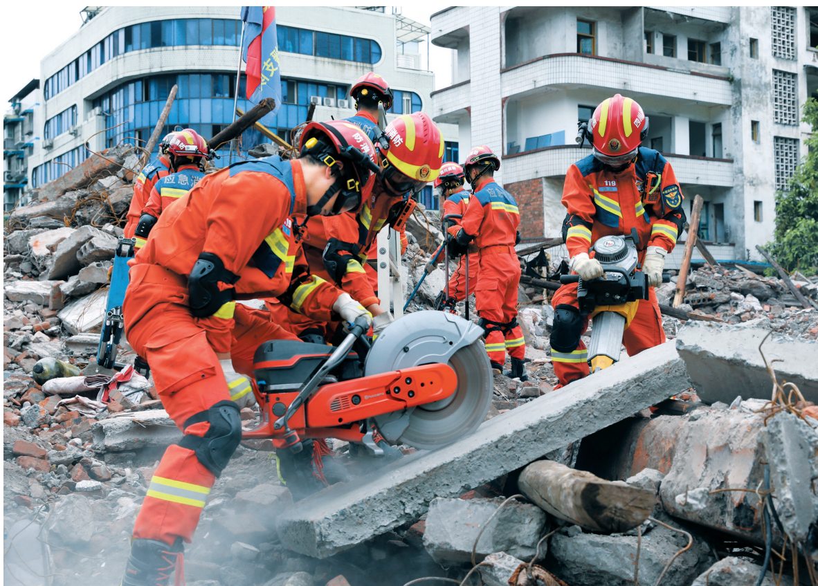
5月8日，乐山应急消防人员在沐川参加实战演练，切割废墟建筑。省应急管理厅供图
