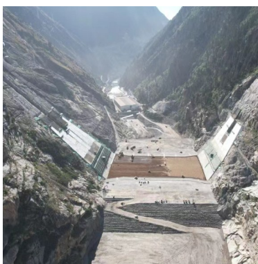
双江口水电站大坝填筑至百米高度。新华社发
