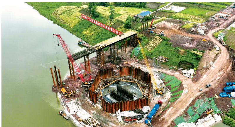
成达万高铁渠江特大桥主墩承台浇筑完成。
