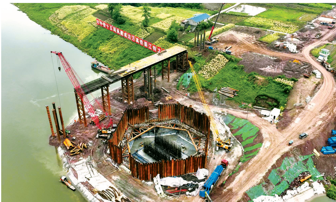
成达万高铁渠江特大桥主墩承台浇筑完成。
