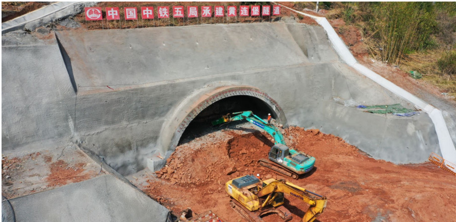
3月30日，成渝地区双城经济圈建设重点工程成渝中线高铁首座隧道——黄连堡隧道顺利进洞开始施工，这标志着成渝中线高铁全线建设进入快车道。 图据新华社客户端
