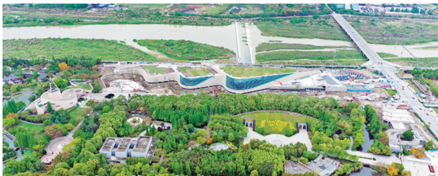
建设中的三星堆博物馆新馆。
