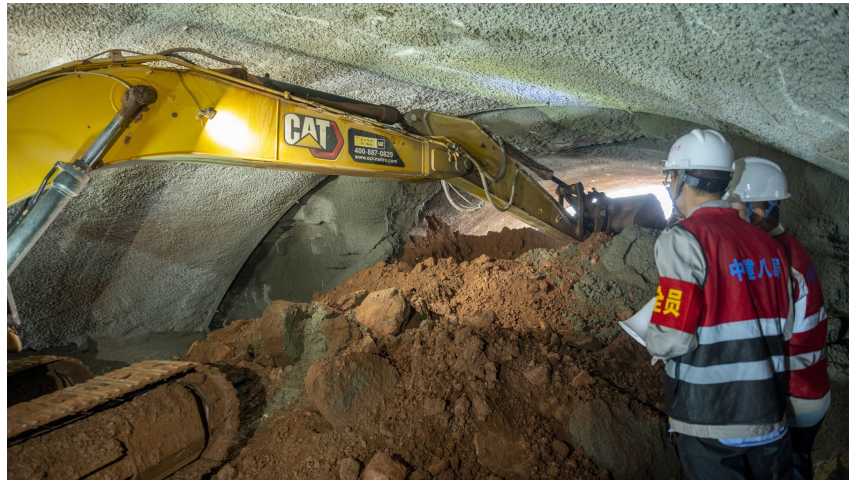
成达万高铁青山隧道最后一米岩体被凿穿。成达万高铁公司供图
