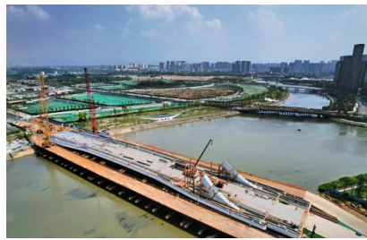
锦尚大桥建设现场。
