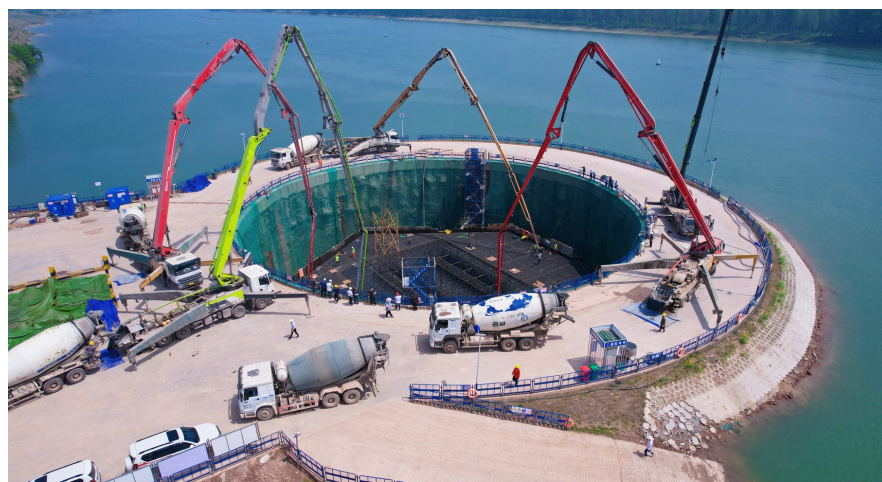
9号主墩承台浇筑现场。成达万高铁公司供图
