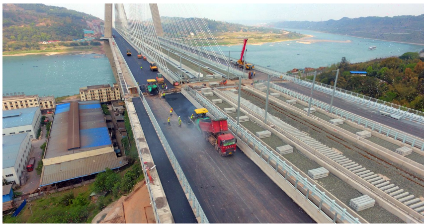
成自宜高铁宜宾临港公铁两用长江大桥公路沥青路面摊铺作业现场。(蜀道集团供图)
