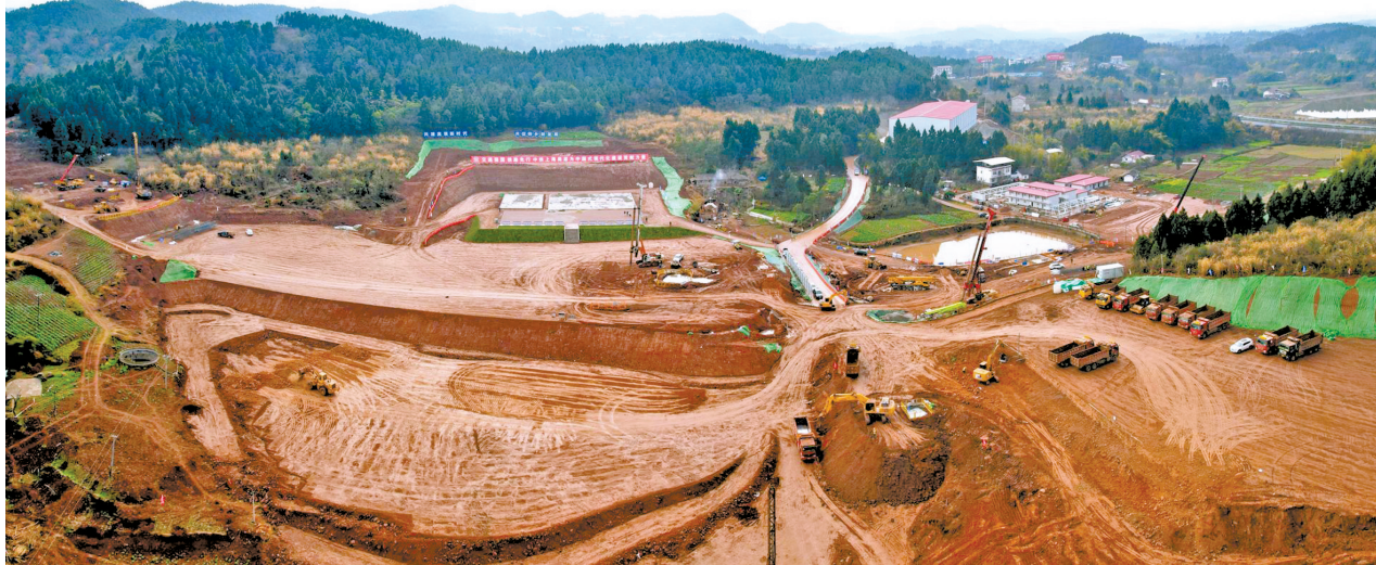
乐至高铁站特大桥项目建设现场。姚阳 摄
