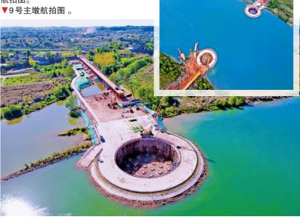
务副指挥长程邦兴介绍,大桥主墩为8 号、9号桥墩,共设60根钻孔桩,桩径2.8 米,其中8号墩桩长42米,9号墩桩长46 米。"相对于传统的'钢围堰+水下开挖' 施工,混凝土咬合桩围堰设计避免了对 水源的污染。"程邦兴说,加上运用 BIM+GIS等数字化和智能化手段,适时 监控整个施工过程,既有效避免了对嘉 陵江水源的破坏,又保护了珍稀鱼类的 生态环境。
